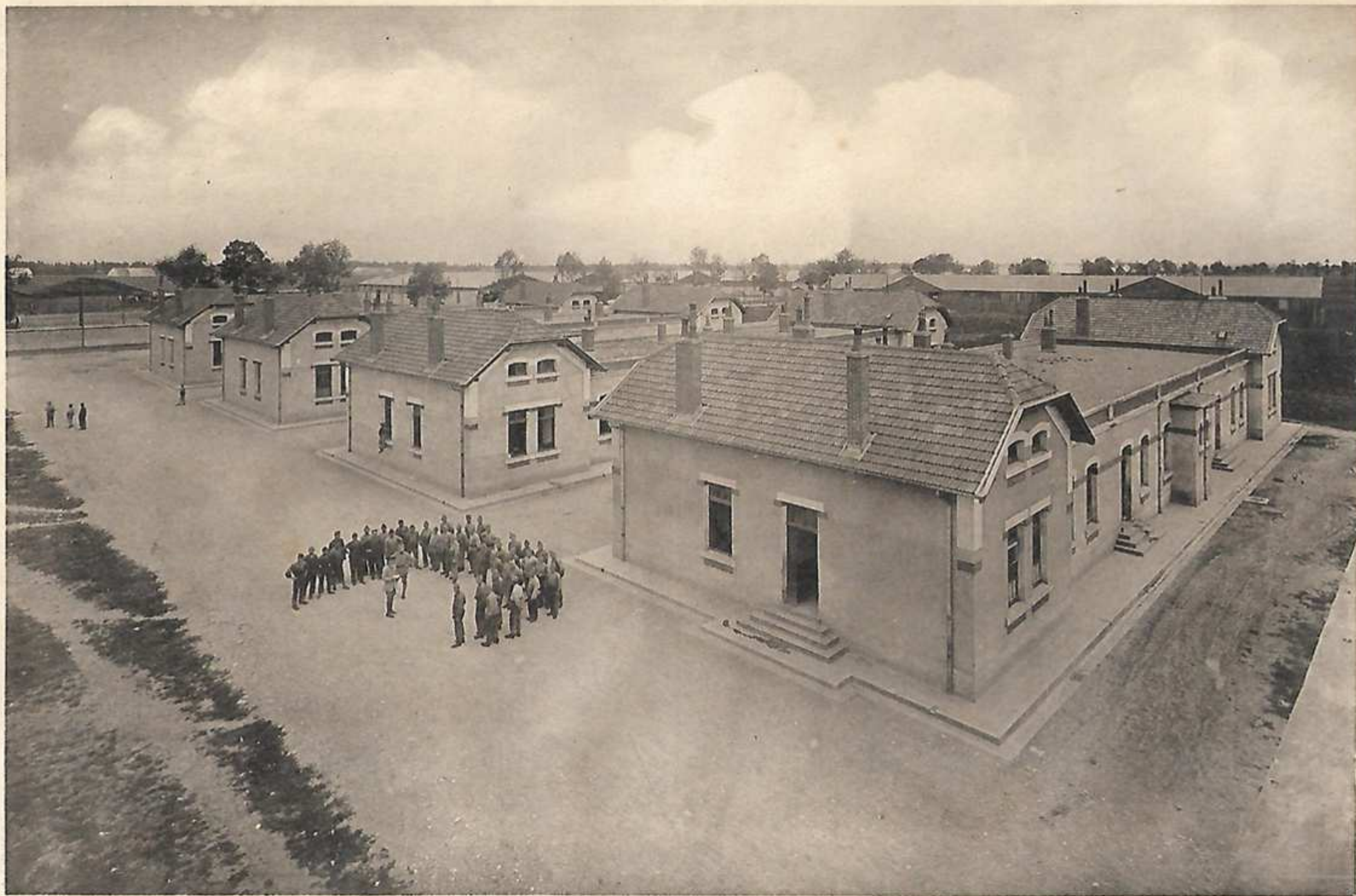
Quartier Ferber (Bâtiments d'Escadrilles)
