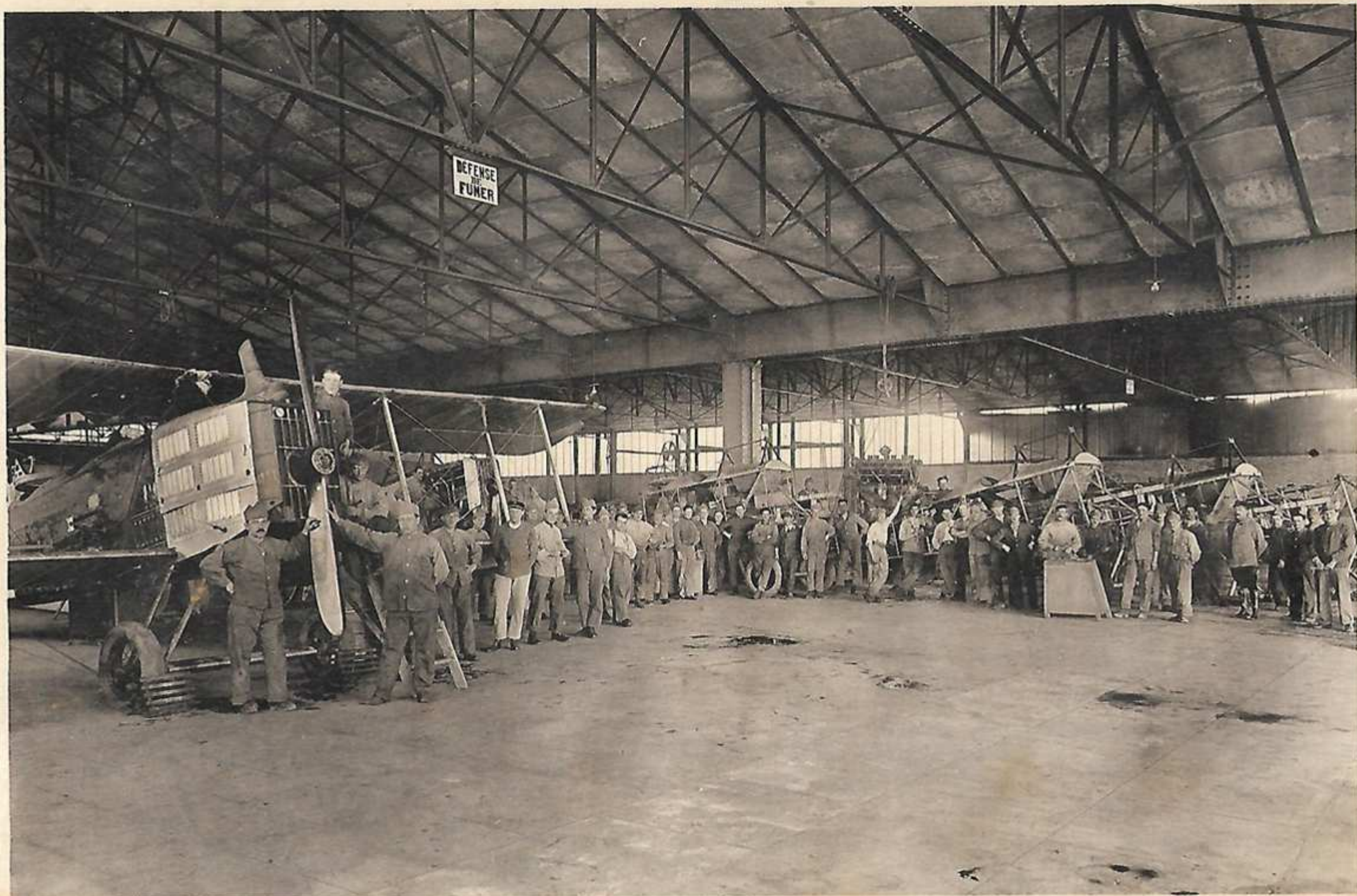
Ateliers de Montage des Avions
