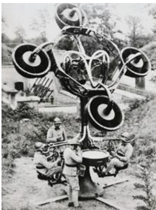
Systèmes de détection acoustique du réseau d'alerte aux bombardements à Paris.
