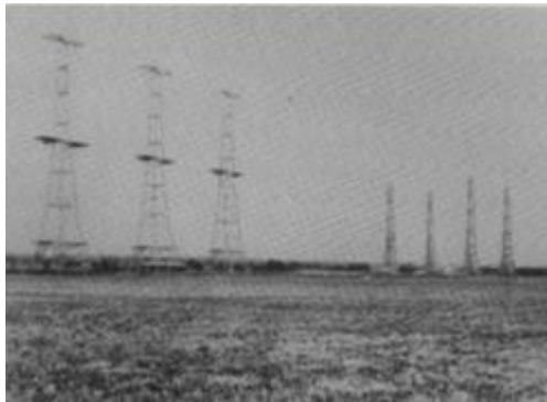
Antennes des émetteurs et des récepteurs d'un radar de la Home Chain
